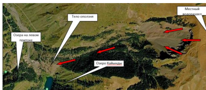
Рисунок 3. Оползень-поток по правому борту р. Кайынды на участке работ
