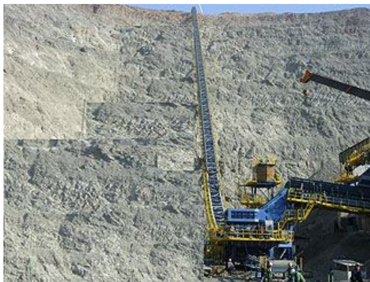
Рис. 1. ЦПТ на карьере «Мурунтау» Навоийского ГМК
