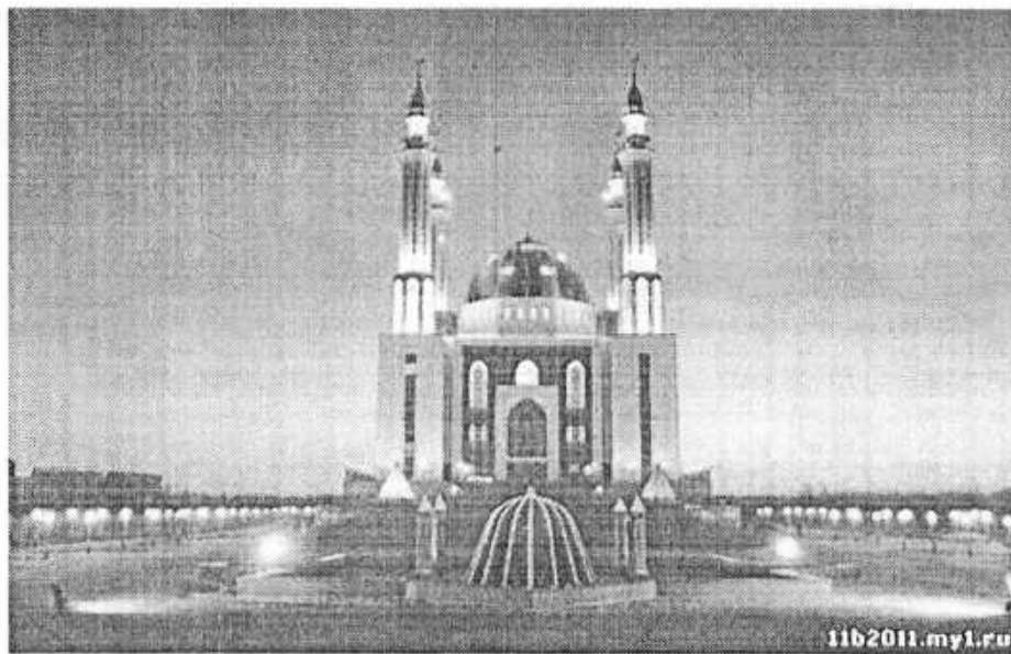
После окончания работ
