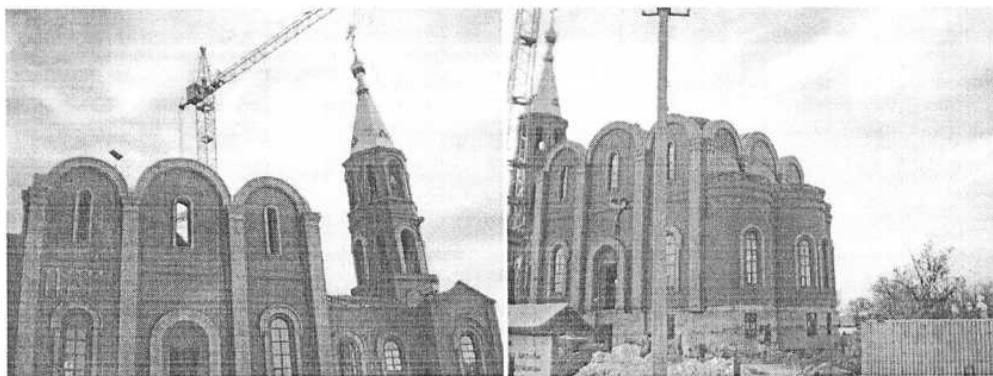
Период строительных работ (фото автора)
