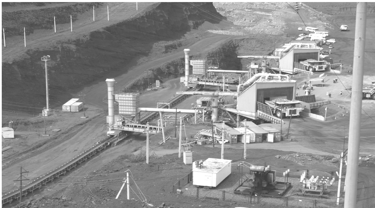
Рис.5. Стационарно-дробильные установки циклично-поточного вскрышного комплекса (ЦПВК) на разрезе «Восточный»
