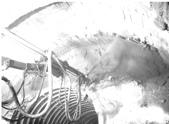
Рис. 3.11. Торкретирование сводовой части СТП (ПК 55+29,600 ÷ ПК 55+26,257) ст. «Байконур» метрополитена г.Алматы
