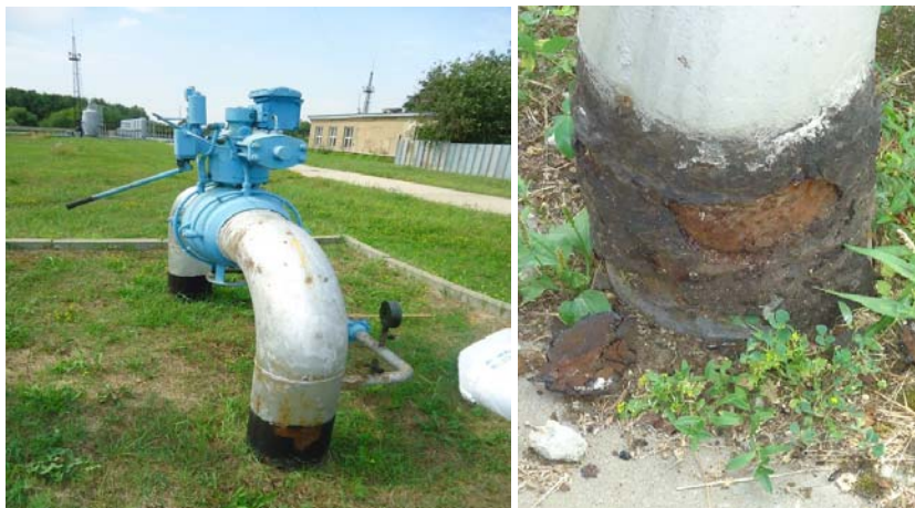
Рис. 1. Участки переходов «земля - воздух» магистральных и технологических трубопроводов
