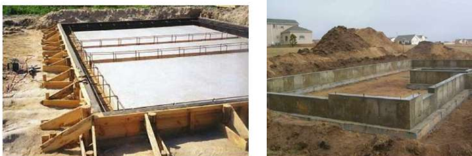
Рис. 1. Неглубокие котлованы, вырытые на каменистых грунтовых основаниях /2/.
