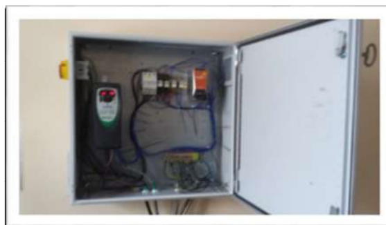
Рис. 3. Силовой шкаф частотным преобразователем
