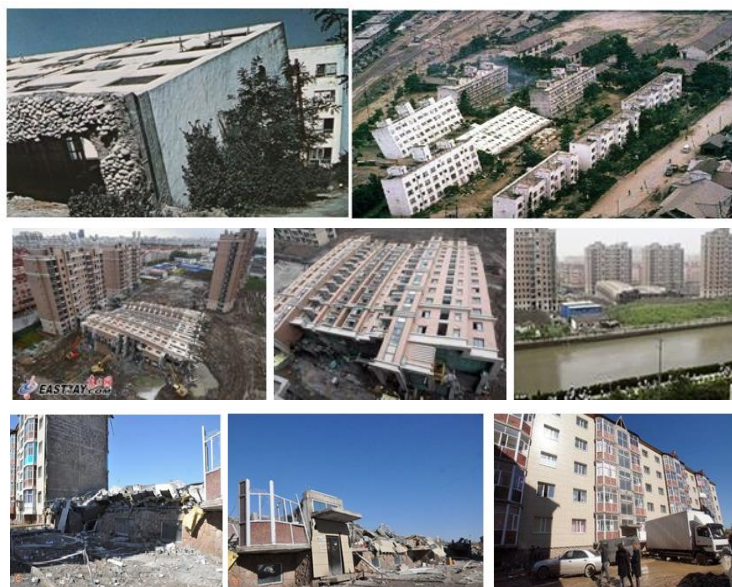
Рис. 1. Накрененные и обрушенные дома в Японии (Ниигата, 1964г.), в Китай (Шанхай, 1913г.) и в Казахстане (Караганда, 2012г) из-за водонасыщения грунтовой оснований.
