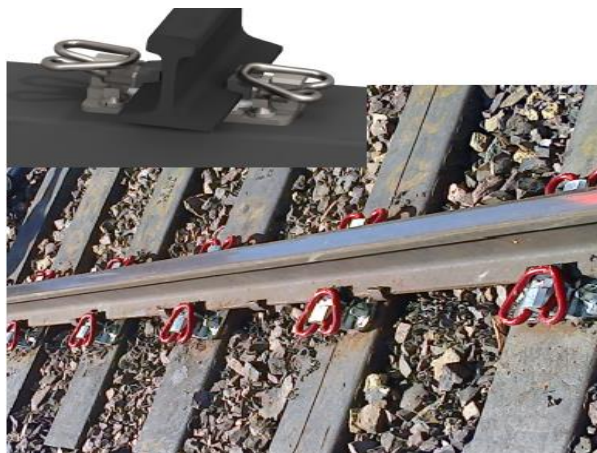
Рис. 1. Участок железнодорожного пути с композитными шпалами со скреплениями «ГРАП»
