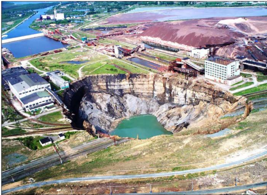
Рисунок 1. Провал на земной поверхности при отработке Верхнекамского месторождения калийно-магниевых солей
