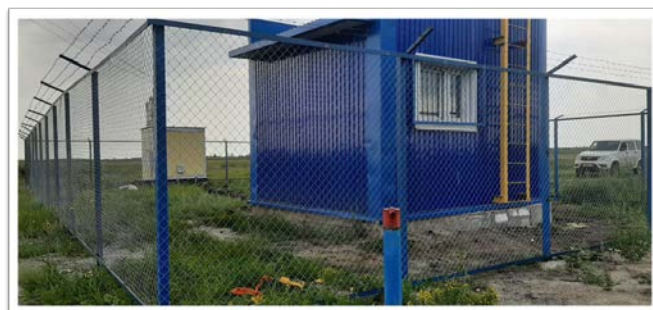
Рисунок 4. Фотография участка водозаборной скважины №21012
